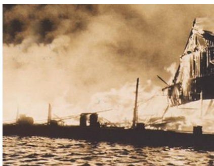
Een witgloeiende vuurzee vrat zich een weg door de Halbertsma-fabrieken te Grouw.
